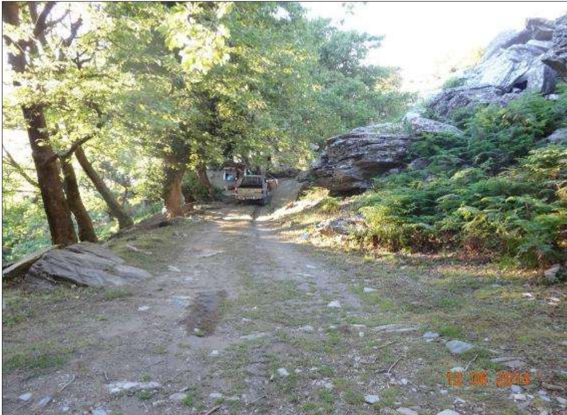
Φωτ.20: Τμήμα νέας οδοποιίας πρόσβασης προς Α/Π Σπηλιά – Σημείο Β.
