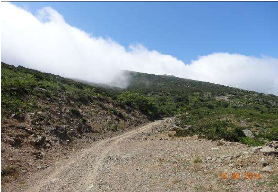
Φωτ.27: Τοπική βελτίωση υφιστάμενης οδού.
